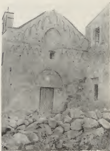
Mogoro - Chiesa del Carmine (facciata).
